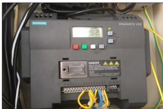
ภาพที่ 27 เครื่องแปลงกระแสไฟฟ้ารุ่น SINAMICS V20
