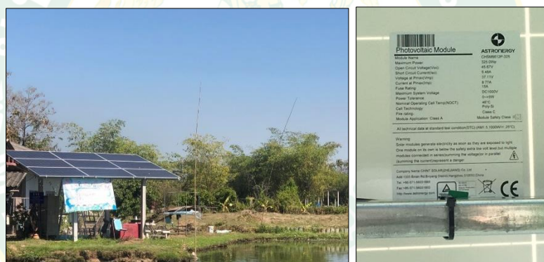
ภาพที่ 24 การติดตั้งแผงเซลล์แสงอาทิตย์
