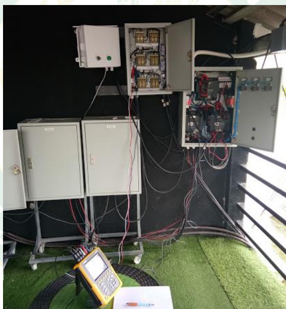
(ข) ภาพรวมการตรวจวัดพลังงานไฟฟ้าที่จ่ายให้กับมอเตอร์สำหรับเติมอากาศ
