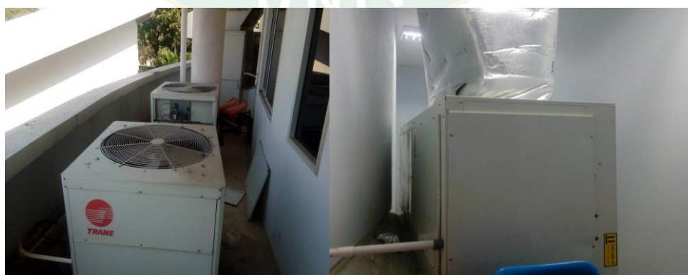
ภาพที่ 77 ลักษณะเครื่องปรับอากาศปรับอากาศแบบชุดหรือแพ็คเกจ (Package) ของอาคาร 70 ปี แม่โจ้
