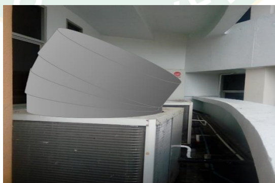
(ข) แนวคิดมาตรการเพิ่มประสิทธิภาพการระบายความร้อนของ Condensing Unit
