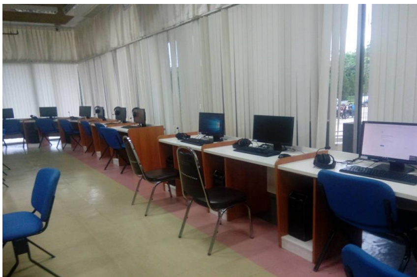
ภาพที่ 52 ตัวอย่างอุปกรณ์ไฟฟ้าภายในอาคาร 70 ปี แมจโจ
