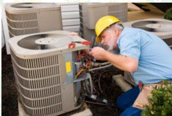
ภาพที่ 7 การตรวจวัดการใช้พลังงานระบบต่างๆ ภายในอาคาร (Energy Audit)
