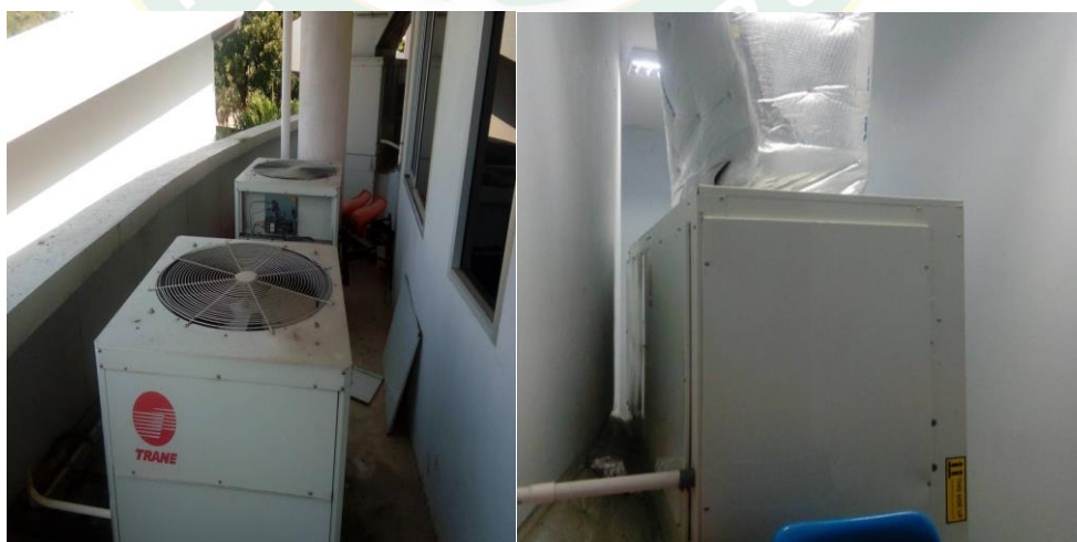
(ข) ลักษณะเครื่องปรับอากาศแบบชุดหรือแพ็คเกจ (Package) ของอาคาร 70 ปี แมงไฉ้
