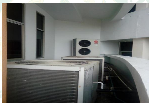
(ก) ลักษณะการติดตั้ง Condensing Unit ห้อง 301/1
