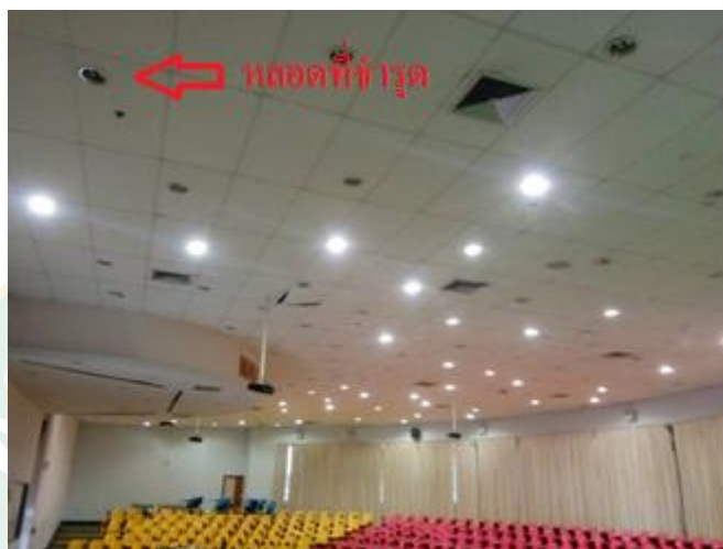
ภาพที่ 71 ลักษณะการติดตั้งหลอดไฟ ห้อง 301
