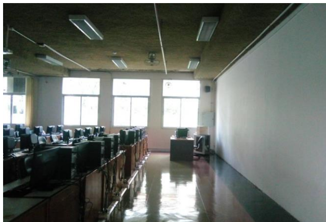
ภาพที่ 72 ลักษณะการติดตั้งหลอดไฟอาคารประเภทห้องเรียนคอมพิวเตอร์
