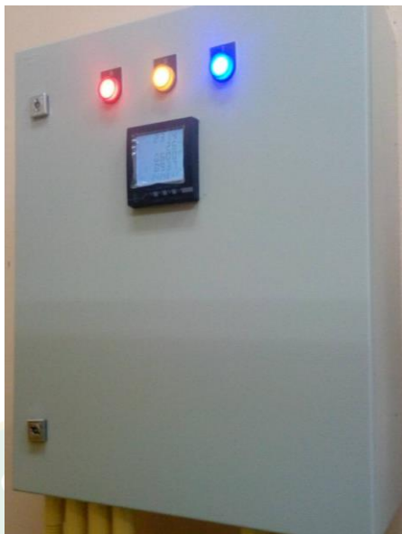
(ข) อุปกรณ์ Datalogger ของอาคาร 70 ปี แม่โจ้
