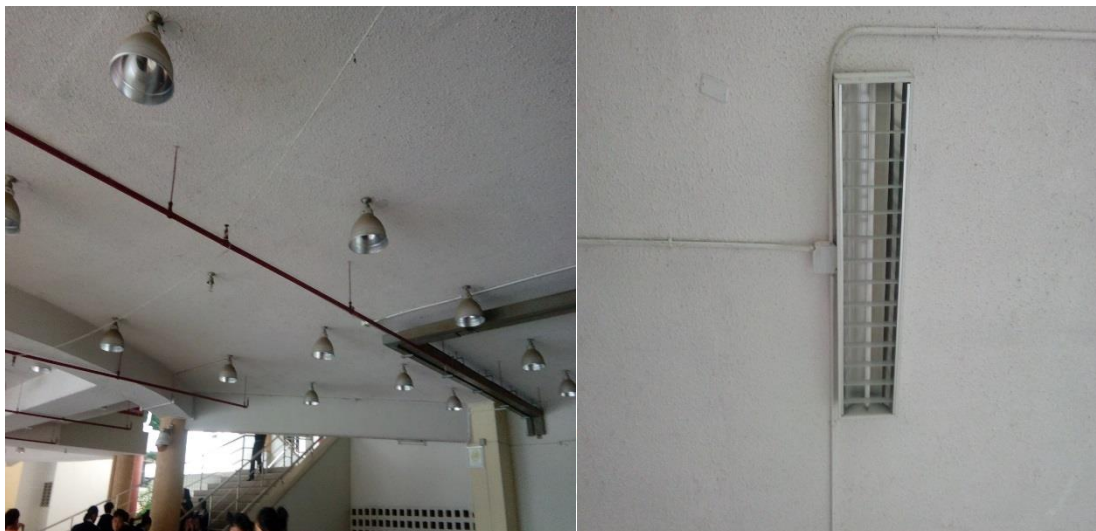
(ค) ลักษณะการใช้งานหลอดคอมแพคฟลูออเรสเซนต์ PLC ทางเดิน
