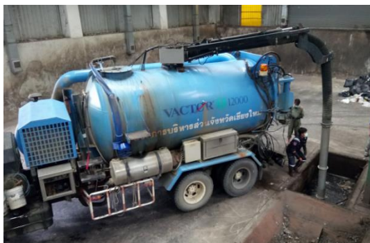
ภาพที่ 8 การทำความสะอาดบ่อสูบน้ำเสีย โดยรถดูดโคลน
