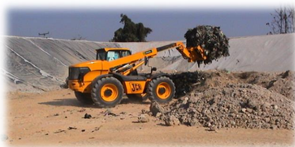
ภาพที่ 7 กระบวนการฝังกลบขยะมูลฝอยเพื่อไม่ให้ส่งกลิ่นและส่งผลกระทบต่อสิ่งแวดล้อม
