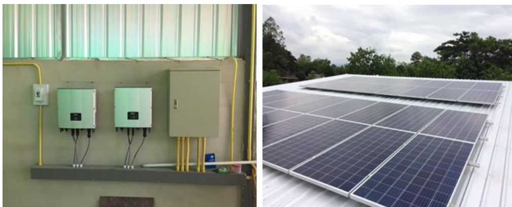
ภาพที่ 8 ระบบผลิตไฟฟ้าพลังงานแสงอาทิตย์ขนาด 11 กิโลวัตต์
