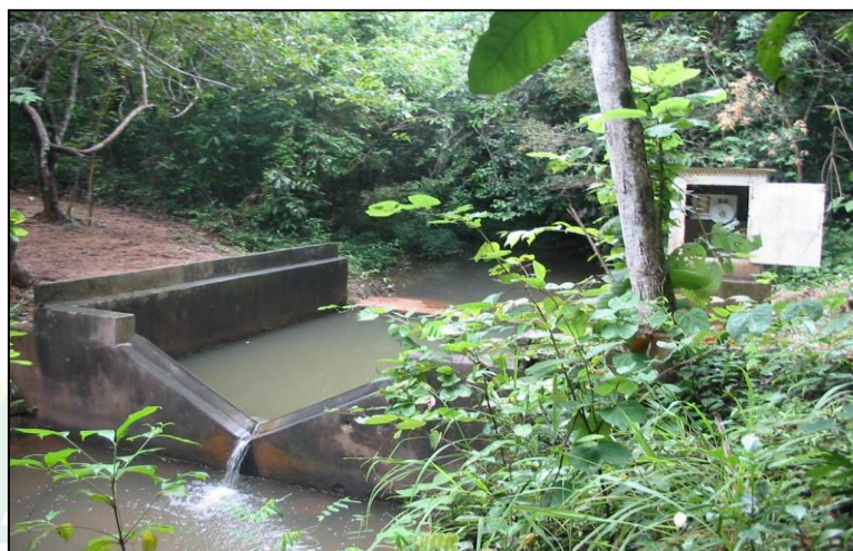
ภาพที่ 8 ฝายต้นน้ำแบบถาวรพัฒนาให้เป็นเครื่องมือวัดปริมาณของน้ำ (อส, 2556)
