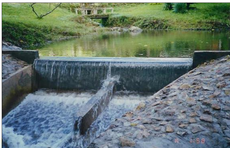
ภาพที่ 7 โครงสร้างทางชลประทานมีลักษณะเป็นฝายน้ำล้น (อส, 2556)
