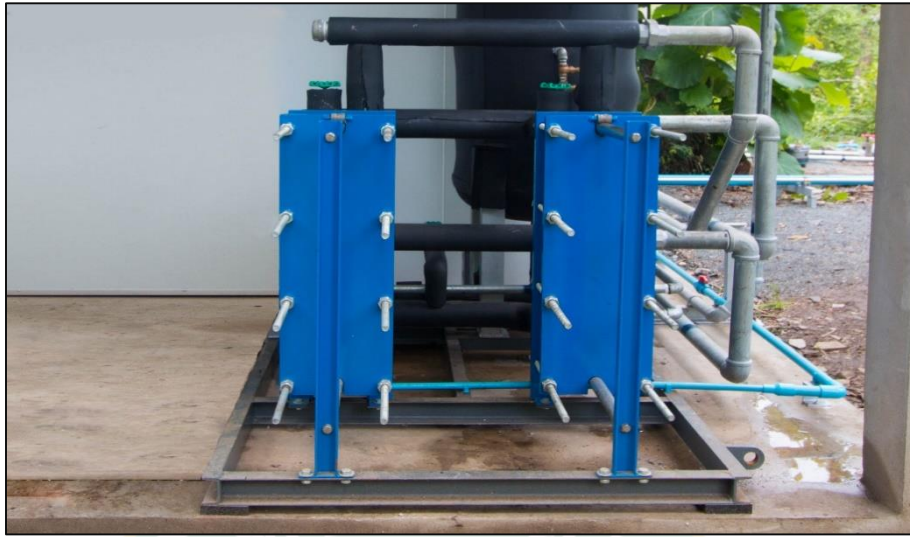
ภาพที่ 29 ชุดอุปกรณ์แลกเปลี่ยนความร้อนแบบถอดประกอบได้
