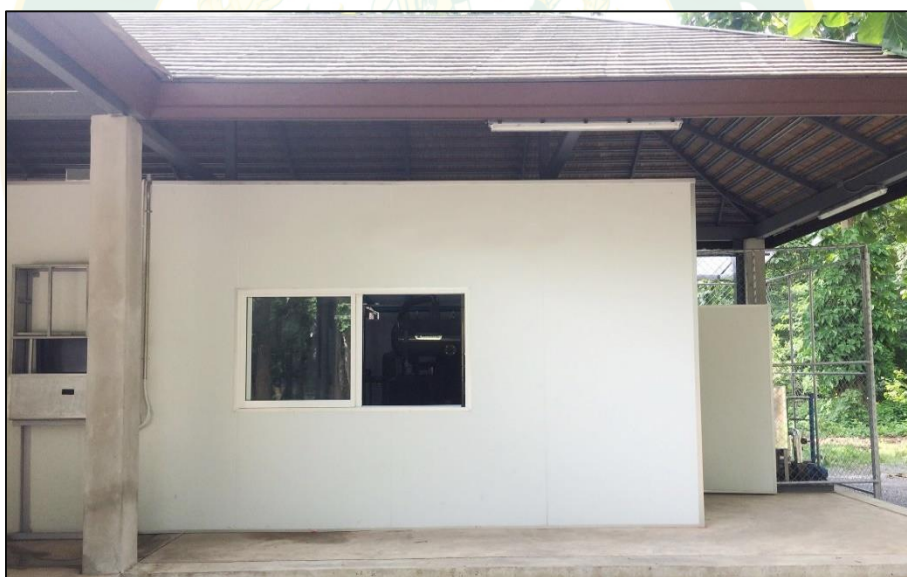
ภาพที่ 35 ห้องระบบผลิตไฟฟ้าด้วยวัฏจักรแรงดันอินทรีย์และระบบทำความเย็นแบบดูดกลืน
