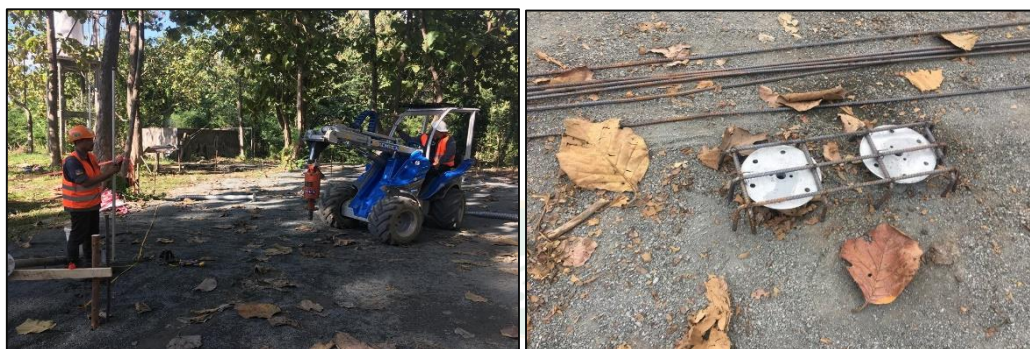
ภาพที่ 31 การสร้างฐานรากด้วยเข็มเหล็ก
