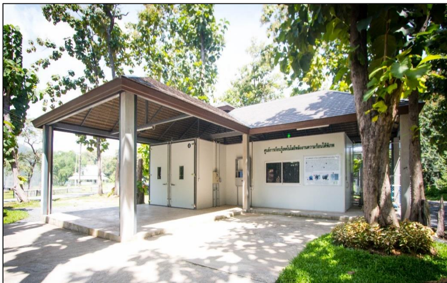
ภาพที่ 34 โรงเรือนหลังการก่อสร้างเสร็จ
