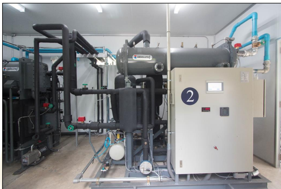
ภาพที่ 21 ระบบผลิตไฟฟ้าด้วยวัฏจักรแรงดันอินทรีย์
