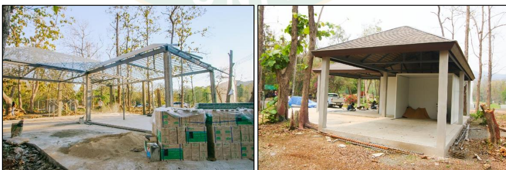
ภาพที่ 33 โครงสร้างหลังคาของโรงเรียน
