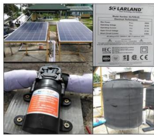
รูปที่ 3 การติดตั้งชุดทดสอบ
