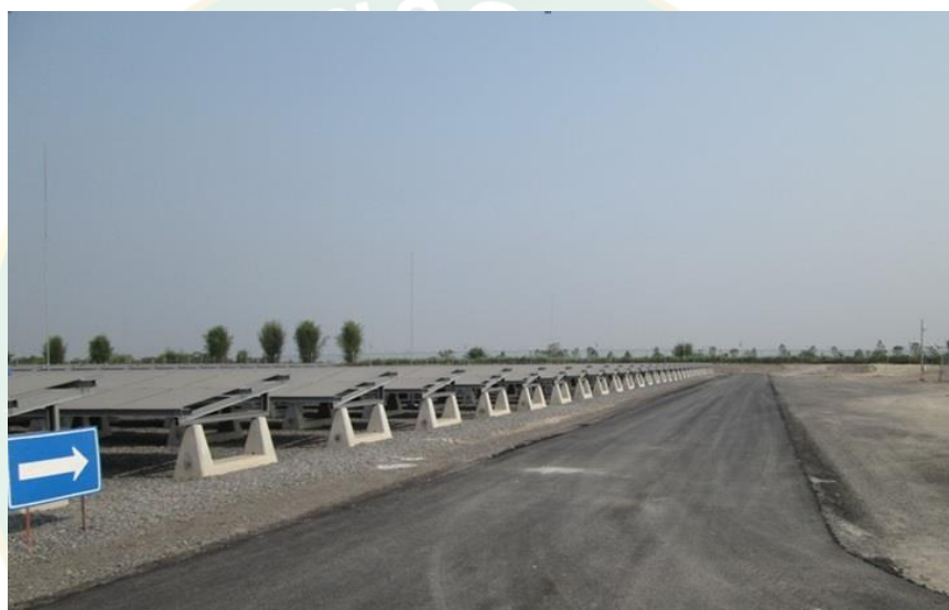
ภาพที่ 30 โครงการโรงไฟฟ้าพลังงานแสงอาทิตย์แบบมุมรับแสงคงที่ ลพบุรี
