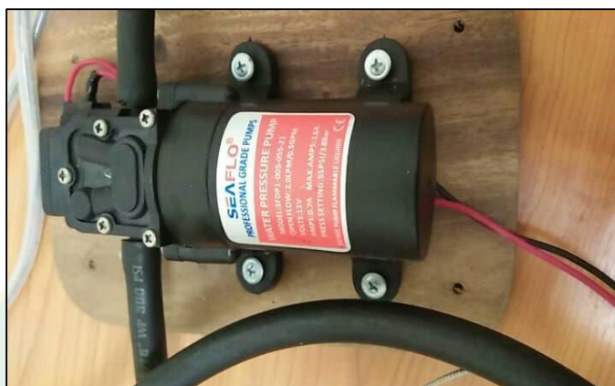
ภาพที่ 34 ปั้มน้ำดีซีขนาด 12V
