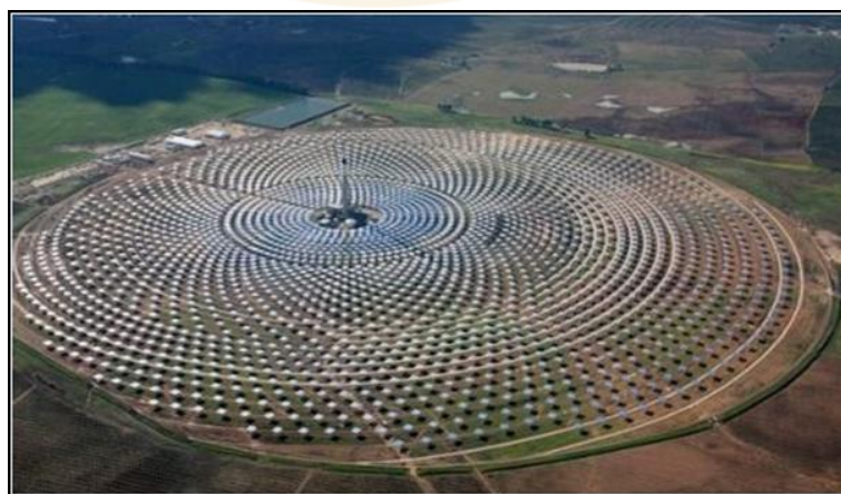
ภาพที่ 9 ระบบหอคอย (Power Tower)
