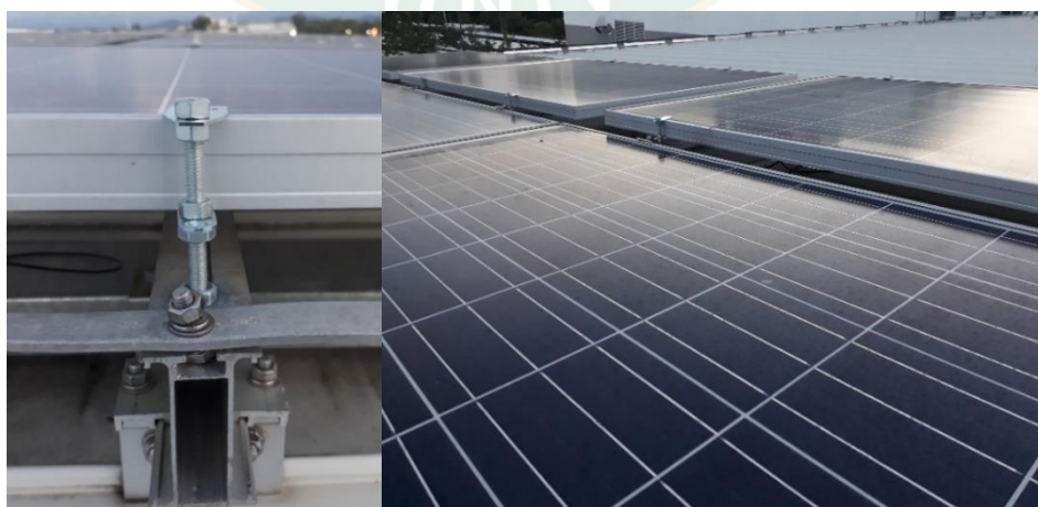
ภาพที่ 52 การยกแผงเซลล์แสงอาทิตย์ ที่ระยะ 25 cm
