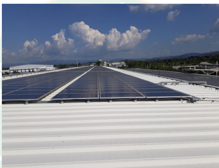
ภาพที่ 7 แผงเซลล์แสงอาทิตย์ที่ติดตั้งบนหลังคาโรงงาน (ภาพจากบริษัทแพนดอรา โพรดักชั่น จำกัด จังหวัดลำพูน)
