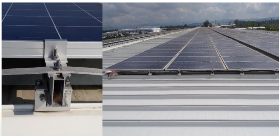
ภาพที่ 51 การยกแผงเซลล์แสงอาทิตย์ ที่ระยะ 20 cm
