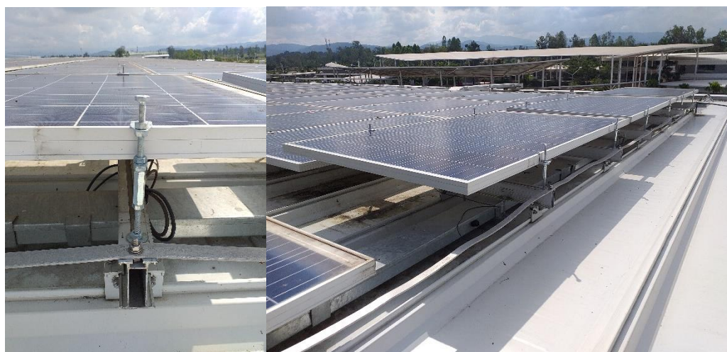
ภาพที่ 53 การยกแผงเซลล์แสงอาทิตย์ ที่ระยะ 30 cm
