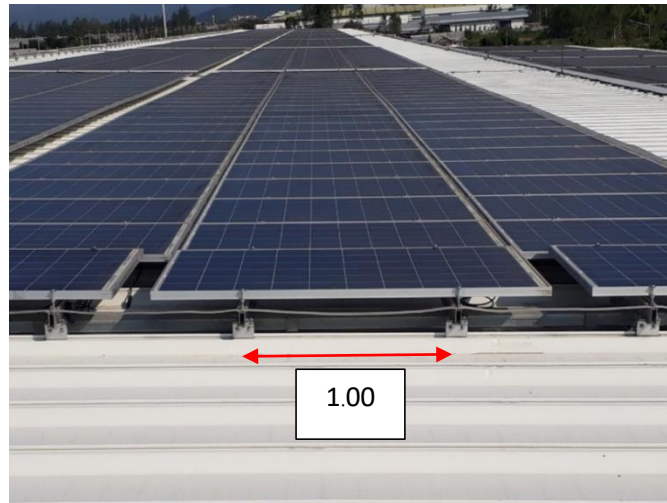
ภาพที่ 58 ระยะห่างของจุดรองรับ ด้านเอียงลาด
