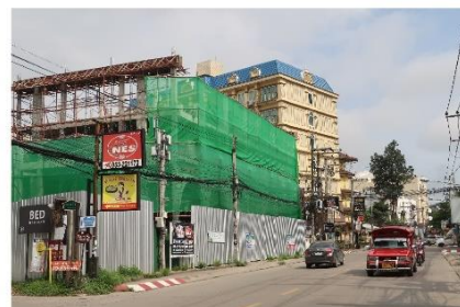
การก่อสร้างอาคารที่อยู่อาศัยประเภทคอนโดภายในย่าน
